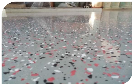
Наливной эпоксидный пол
