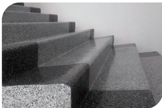
Наливной эпоксидный пол
